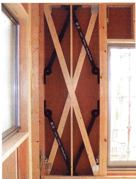
アイ・エム・エーの「GVA 60S」の施工例。たすき掛け筋かいに干渉しないように、制振装置を取り付ける
