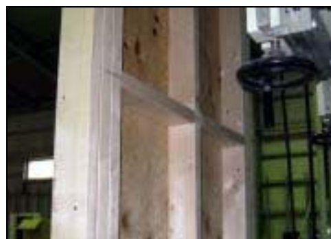
写真6 GVA仕様の間柱（中央付近）
