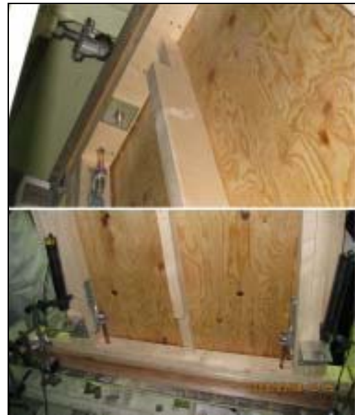
写真 8 破壊状態の間柱端部（上下部分）
