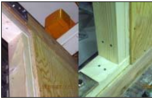
写真 1 構造用合板の取り付け（梁勝ち）
